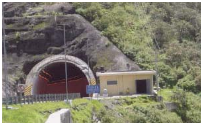
Figura 7.31 Casa de máquinas (Dominio Público)
