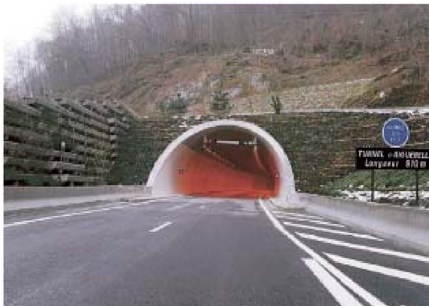
Figura 7.20 Zona de acceso igual a la distancia mínima de seguridad de frenado (Túnel al sur de Francia) (Dominio Público)
