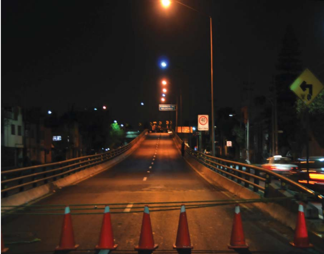
Figura 5.14 Avenida con lámparas de vapor de sodio alta presión y lámparas con aditivos metálicos
