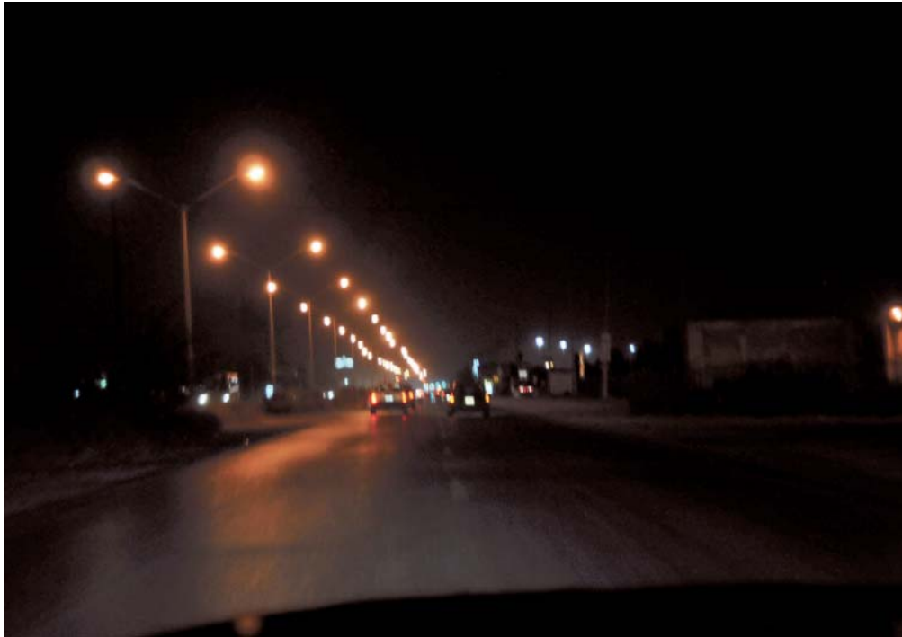
Figura 5.8 Boulevard iluminado con luminarias OV non cut-off
