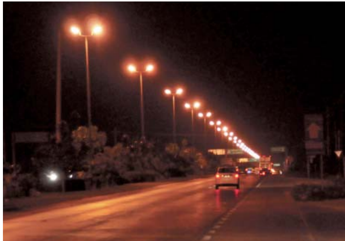
Figura 1.19 Ejemplo de deslumbramiento molesto, al utilizar luminarias con refractores (Dominio Público)
