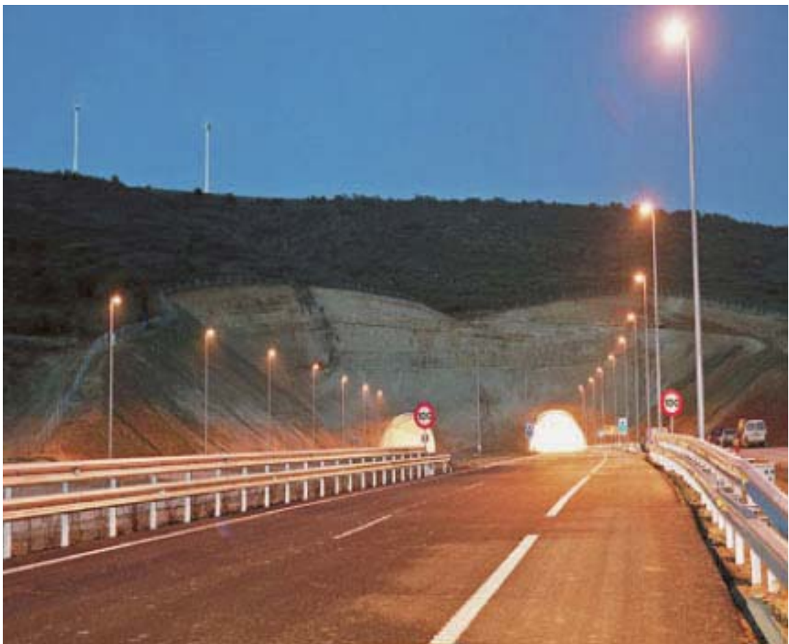
Figura 7.1 Alumbrado de túnel (Túnel Cartagena, España) (Dominio Público)
