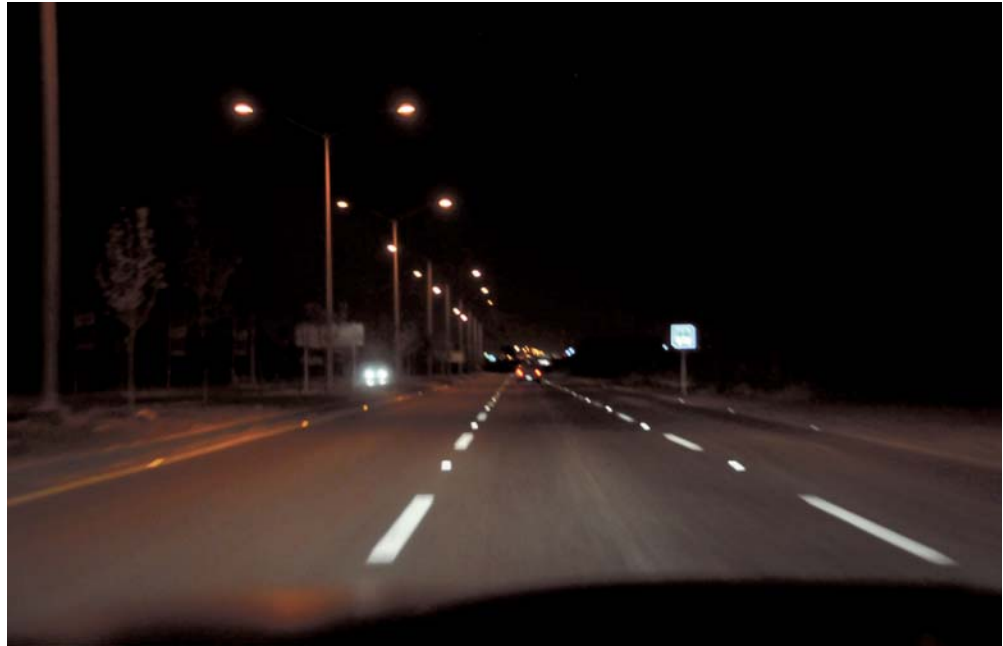
Figura 5.6 Boulevard iluminado con luminarias cut-off
