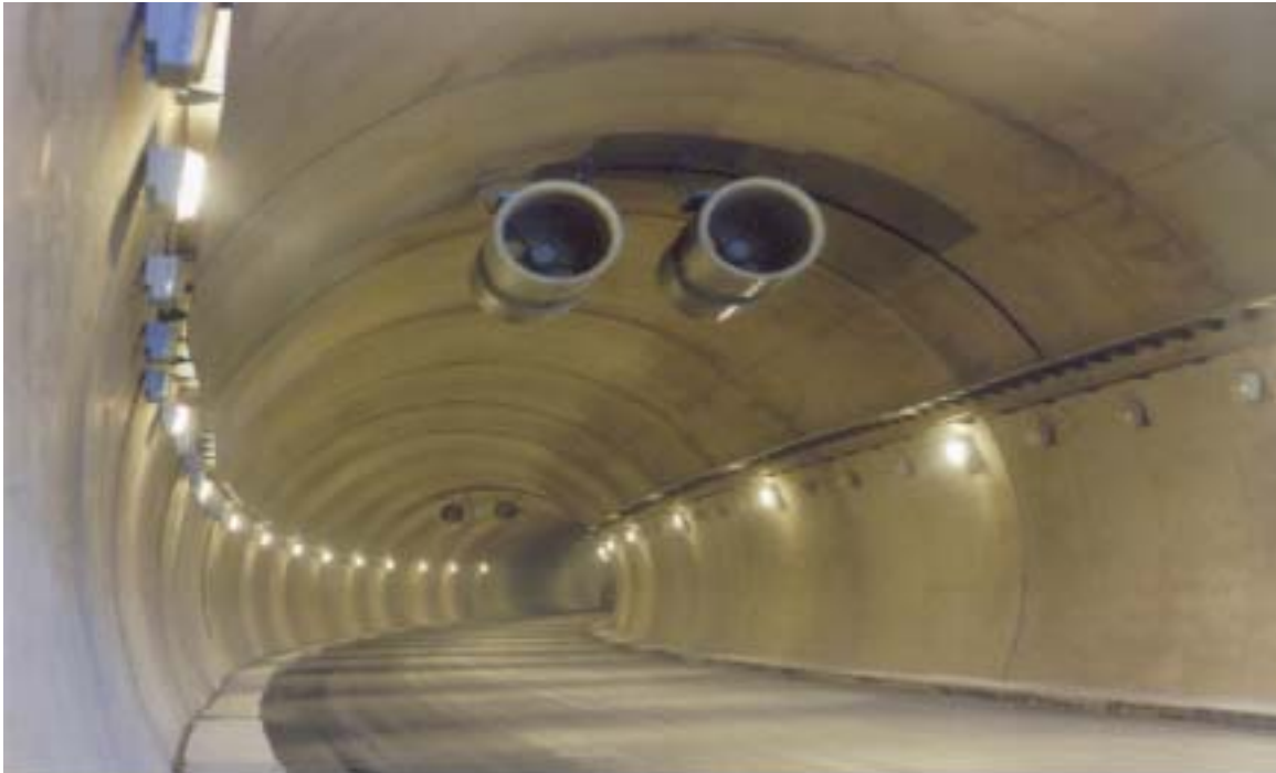
Figura 7.25 Zona central (Túnel en España) (Dominio Público)
