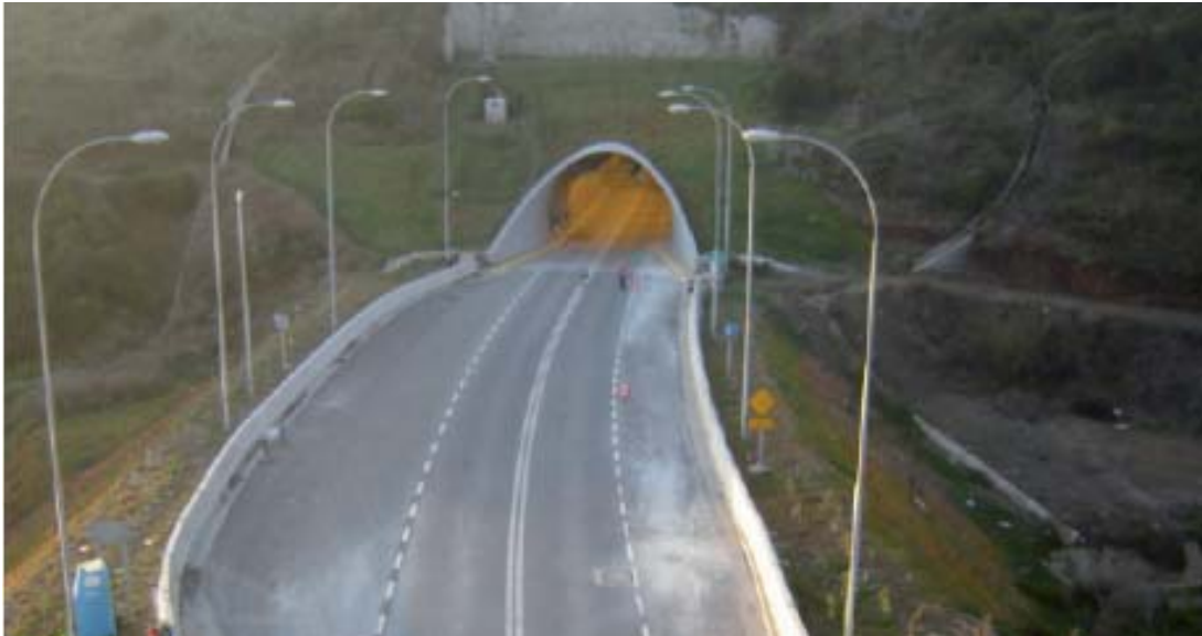
Figura 7.3 Túnel iluminado (Túnel en Suiza) (Dominio Público)
