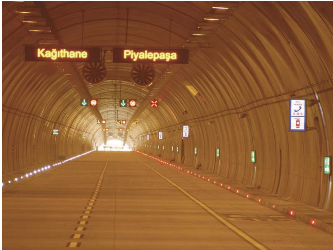
Figura 7.33 Señalizaciones de emergencia (Túnel en Austria) (Dominio Público)
